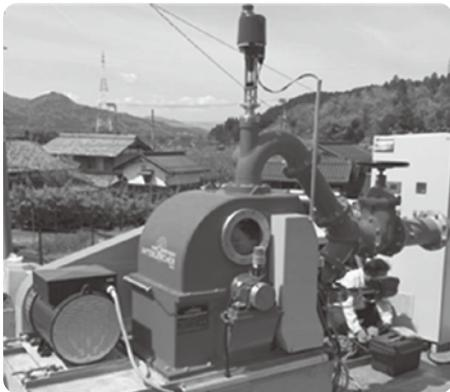
ペルトン水車とは、水流の衝撃を利用した衝動水車です。羽根車（ランナー）に水流を入射し、回転力を得る水車で、高い水圧を利用する高落差の場所に適し、水量に対しジェット水流を調節することで、高い発電効率を実現します。
